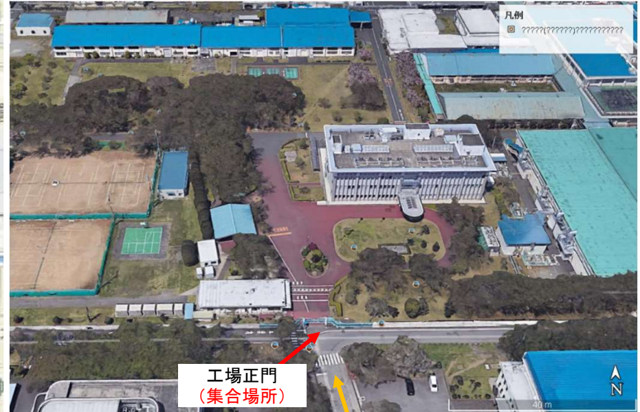
国道1号線から
